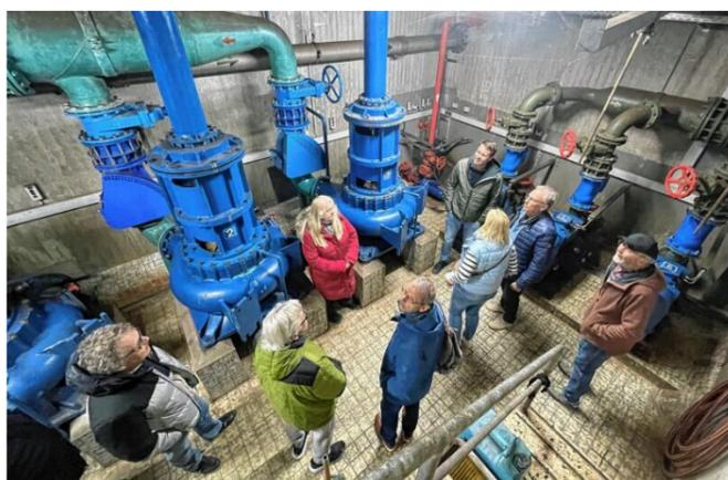
Tief unter der Erde am Mantelhafen: Die Pumpstation, in der das Abwasser des Ufersammlers auf ein höheres Niveau gepumpt wird. Foto: Hanspeter Walter
